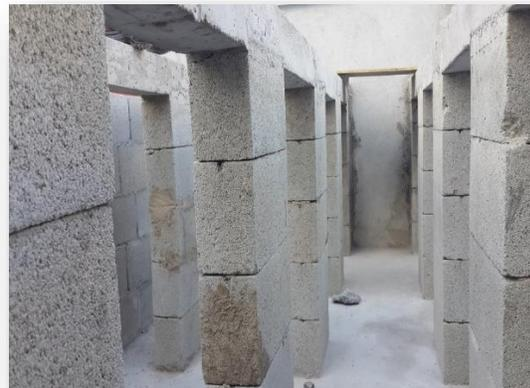
Todas as margens da área onde for aplicado este revestimento deverá ser travado com alvenaria ou outro dispositivo que mantenha estável e firmemente justo as peças aplicadas.
